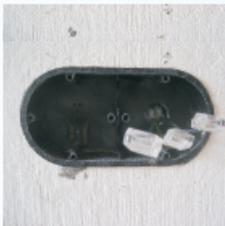
Alle Steckdosen oder Lichtschalter versetzen Sie um die Plattenstärke nach vorne. Die erforderlichen Ausschnitte sind mit dem Dosenfräser herstellbar (Dosenverlängerungen im Fachhandel erhältlich).
