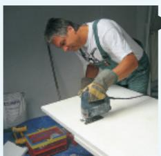
Mit einer Abmessung von 1.000 mm x 750 mm sind die Platten durch nur eine Person problemlos zu verarbeiten. Sie werden mit einem Bleistift angezeichnet und mit einer handelsüblichen Säge (Fuchsschwanz, Pendelhub- oder Tauch- bzw. Kreissäge mit Absaugung) einfach und passgenau zugeschnitten. Ein nachträgliches Hobeln oder Schleifen ist ebenfalls möglich. Reststücke und Abschnitte können an anderen Stellen verwendet werden.
