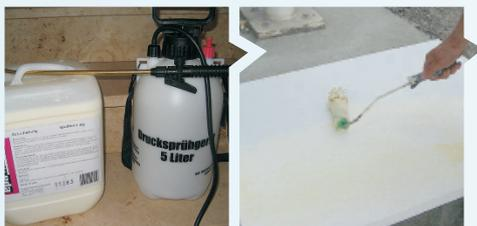
Nach dem Zuschritt wird die dazugehörige Grundierung unverdünnt allseitig und auf alle Platten aufgetragen (mit Farbroller, Streichquast oder Sprühgerät), somit wird dem Plattenkleber nicht vorschnell das Anmachwasser entzogen.
