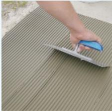
Den Kleber nun vollflächig mittels Zahnpachtel (10 bis 12 mm) oder Mittelbettkelle auf die grundierte Plattenrückseite oder auf die Wand aufbringen.
